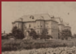
■ 八角塔樓拆除後 [1906年左右]
