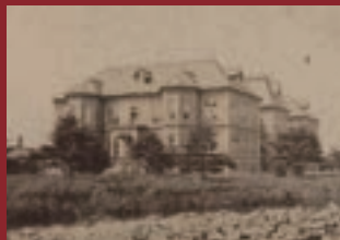
■ 八角塔楼拆除后 [1906年左右]
